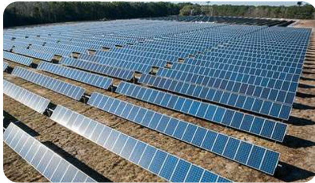
Primera planta solar fotovoltaica
